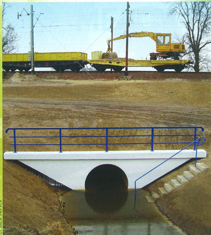
FOT. ARCH. PKP PLK
