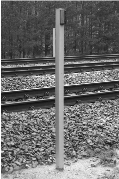
RYSUNEK 3. Zamontowany odbłask na odcinku linii kolejowej E65 (fot. K. Jasińska) FIGURE 3. Mounted reflection on E65 railway line (photo K. Jasińska)
