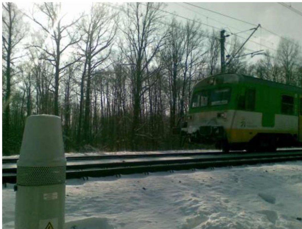
UOZ-y, czyli urządzenia odstrasżające zwierzęta od torów kolejowych gdy zbliża się pociąg
